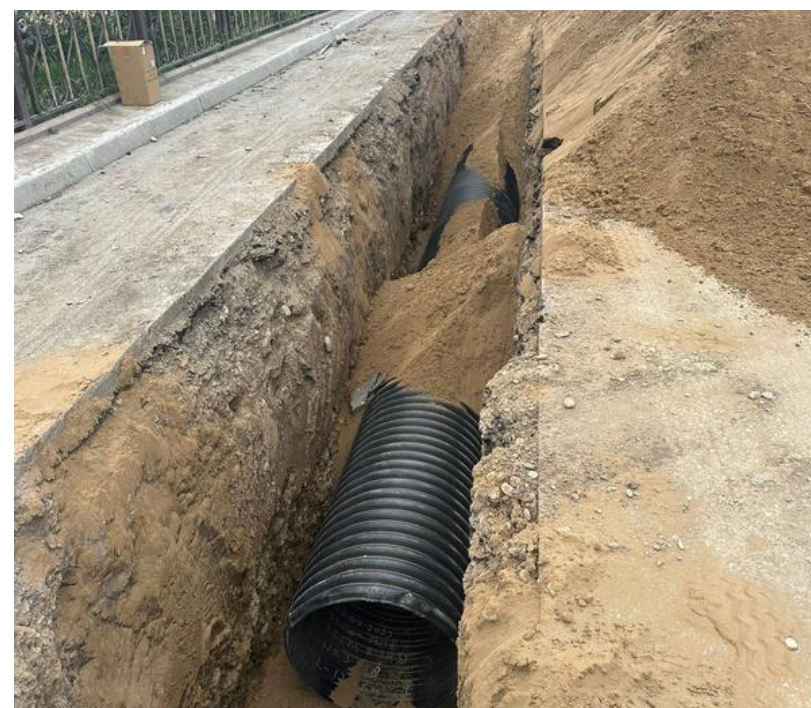
Реконструкция сетей водоотведения г. Хасавюрт 2022-2024
