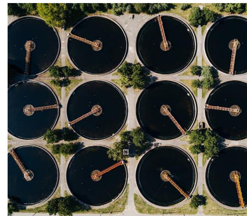
Строительство очистных сооружений канализации г. Дагестанские Огни 2024-2026
