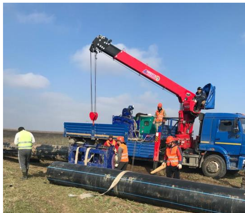
Строительство водовода «Кайтаг-Дербент» 2022-2025
